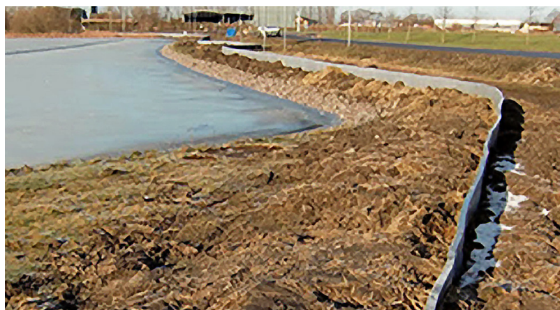
Mjukt formad markspärr med AQVIS Miljöspont.
