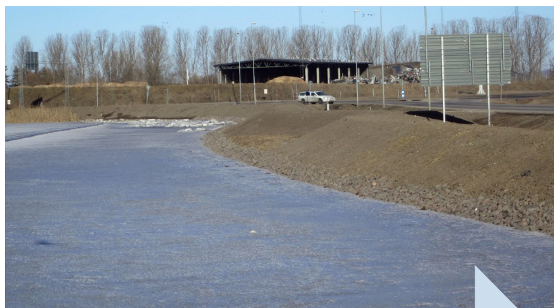
Den färdiga vallen mellan lakvatten- och dagvattendammen.
