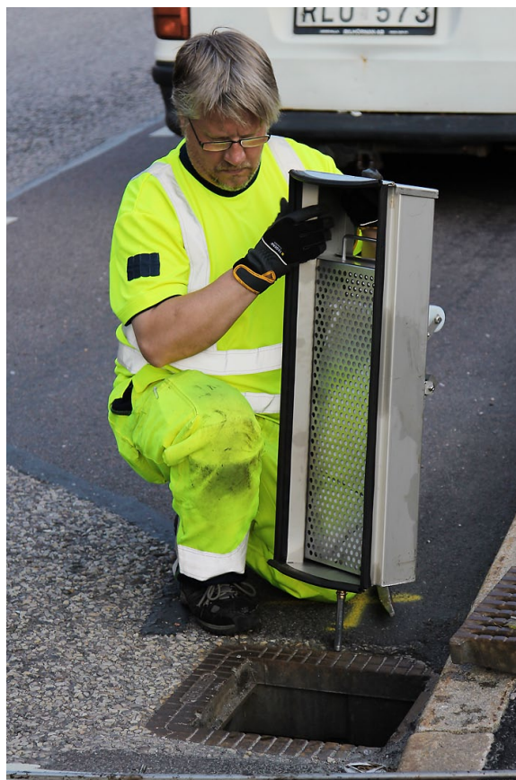
Montering av FlexiClean filterkassetter utanför Sahlgrenska sjukhuset, Göteborg.
