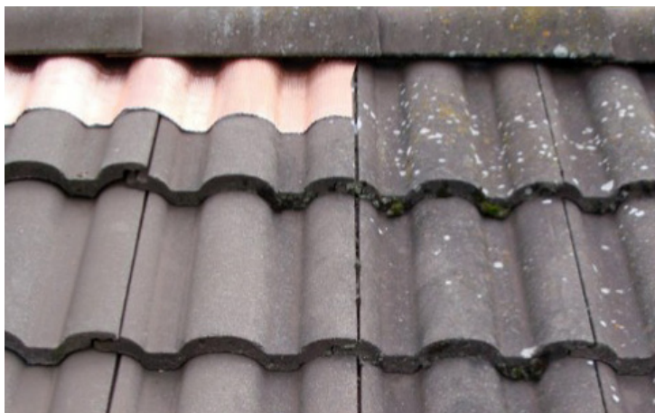
Ett tydligt exempel på koppars effekt på mikroorganismer syns på bilden där en bit koppar fästs under nockpannorna på ett tak. Ytan nedanför koppars är helt rent jämfört med betongpannorna till höger.
